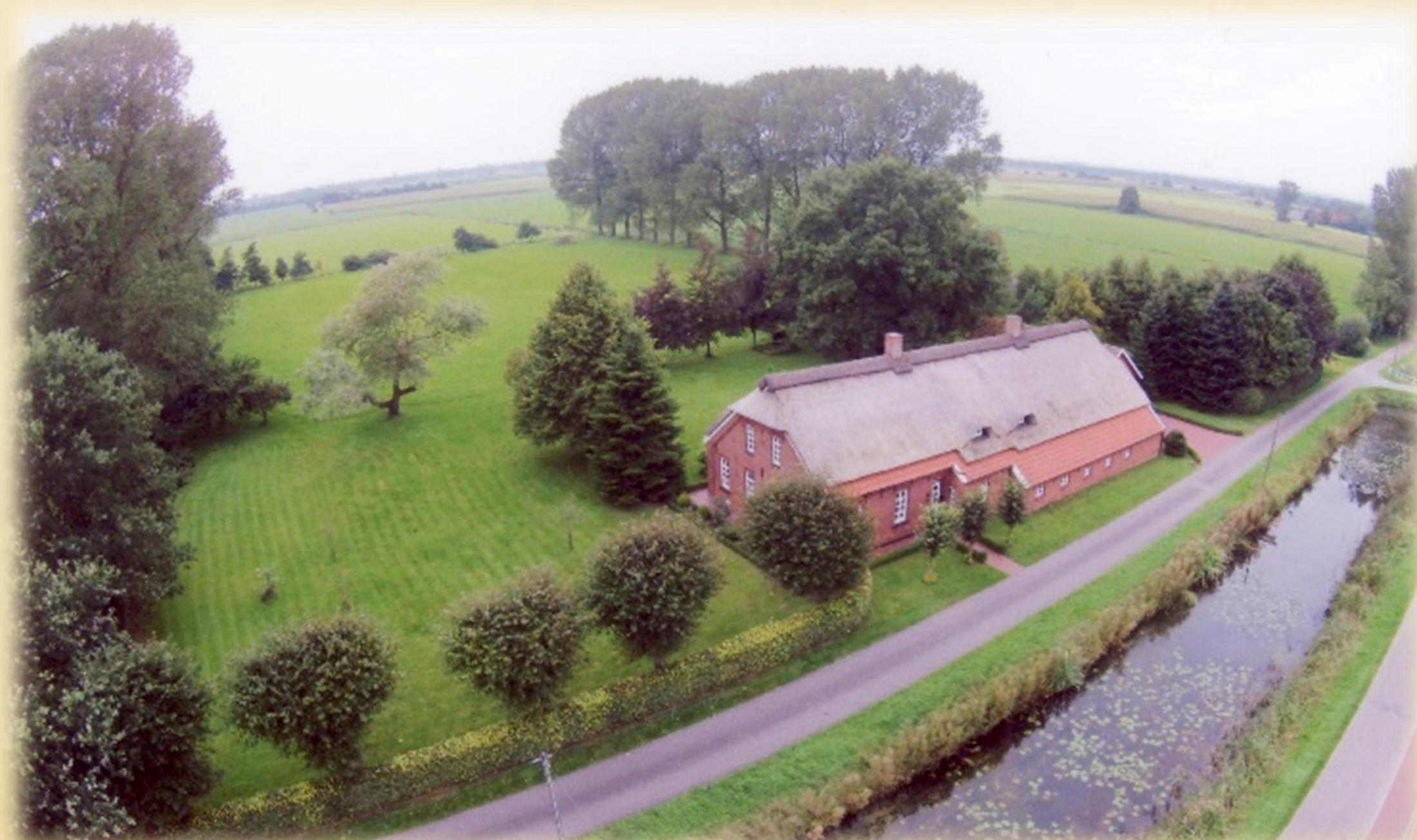
Restaurierter Gulfhof heute
