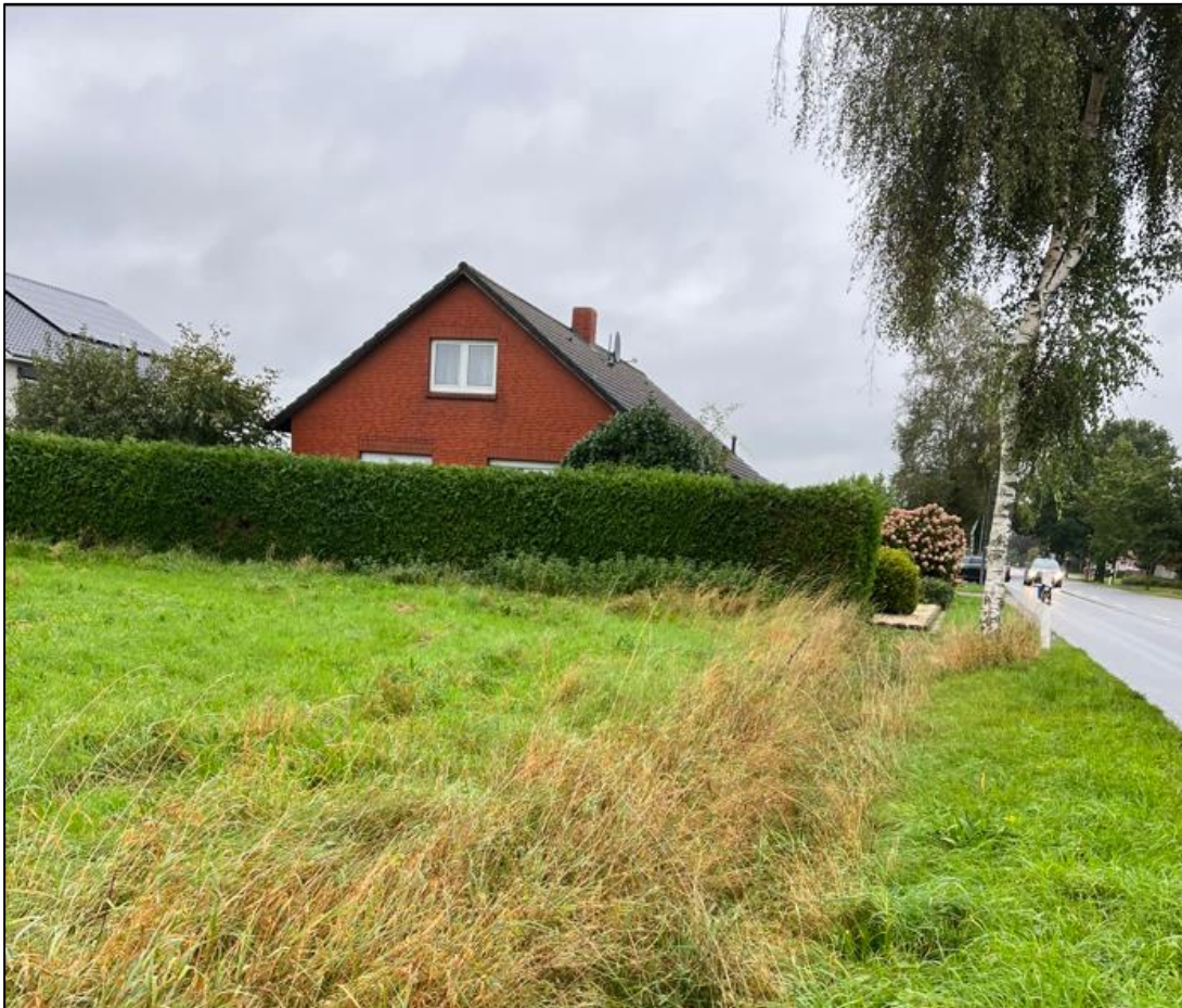
Abbildung 9: Rodung Birke und 16 m Verrohrung Graben für Zuwegung Parkplatz
