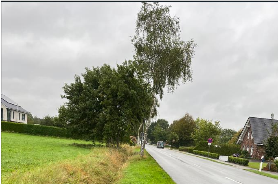
Abbildung 8: Rodung Birke und 13 m Verrohrung Graben für Ein-Ausfahrt Einsatzfahrzeuge
