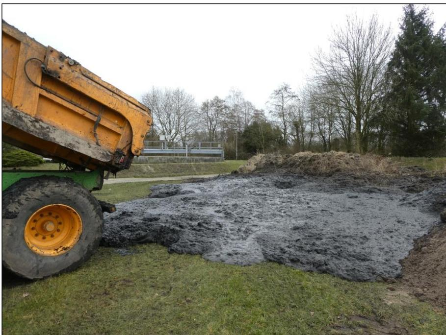
Abbildung 10: Der Schlamm wurde auf einer Grünfläche auf dem Gelände der Kläranlage ausgebracht.
