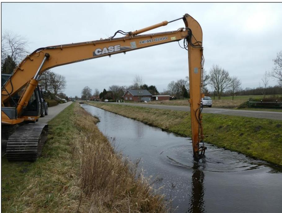
Abbildung 7: Die Entnahme des Schlammes erfolgte mit einem Langarmbagger.
