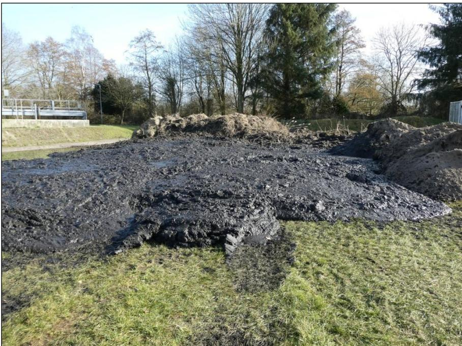
**Abbildung 12: Schlammfläche nach Ende der Aufbringung.**
