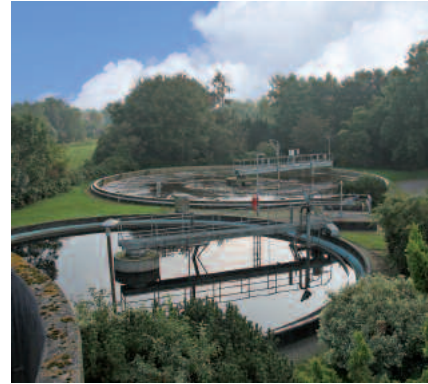
Das Klärwerk an der 3. Norderwieke in Warsingsfehn
