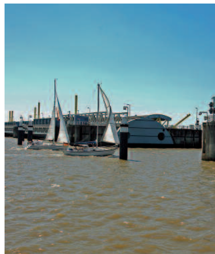
Emsperrwerk in Moormerland-Gandersum
