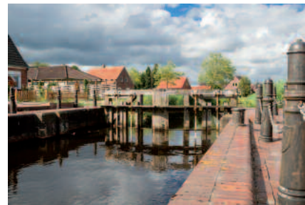
Die Schleuse in Warsingsfehn diente viele Jahrzehnte den „Fehntjern“ und ihren Schiffen bei der Bewältigung der verschieden hohen Wasserstände.
