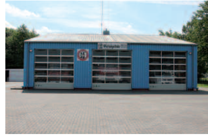
Das Feuerwehr-Gerätehaus in Warsingsfehn an der 3. Norderwieke.
