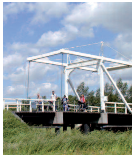
Die Leidsebrücke zwischen Ayenwolde und Tergast erinnert an Zeiten, als das „Fehntjer Tief“ noch von Torfschiffen genutzt wurde.
